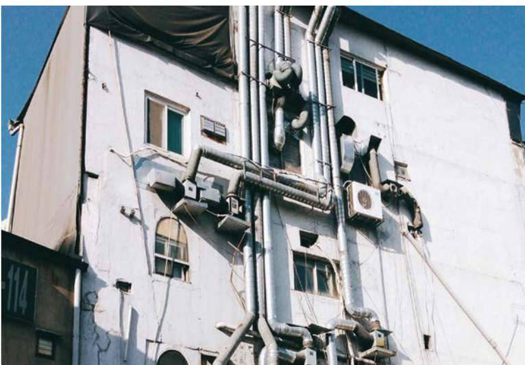
**Abbildung 4:** Verwendung von F-Gasen als Kältemittel in der Gebäudetechnik. Konglomerat an Klimaanlagen an einer Häuserwand (@Nessa Altura, unsplash).
